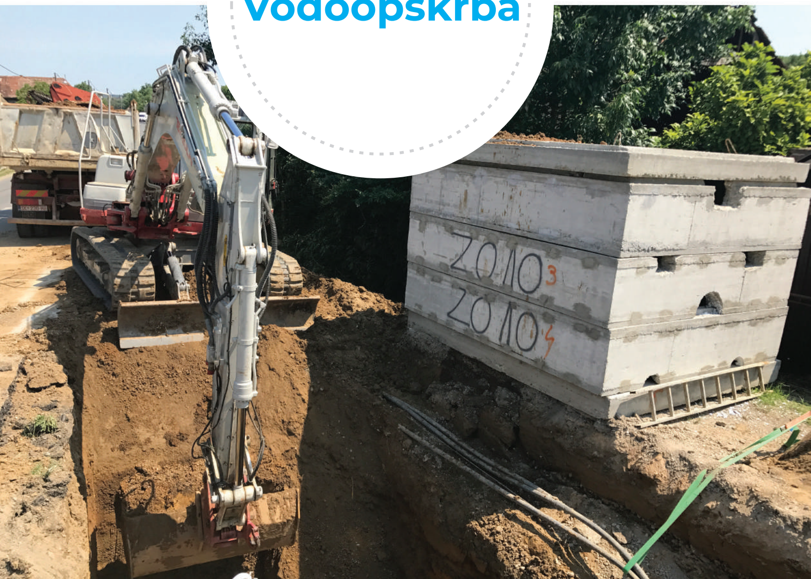
Izgradnja magistralnog vodoopskrbnog cjevovoda Petrinja - Lekenik
